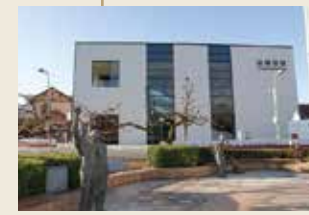
2020.3.2 山梨市駅新駅舎
