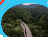
雁坂トンネル入口
