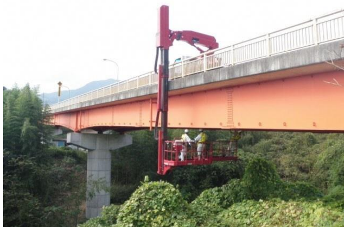
写真1 定期点検状況
