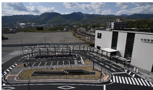
山梨市駅南口広場
