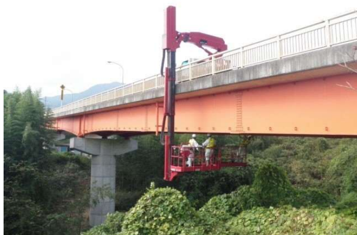
写真1 定期点検状況
