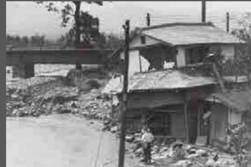
昭和34年に襲来した台風7号と伊勢湾台風により、市内は甚大な被害を受けた。清水橋では橋桁に引っかかった流木で橋がめくりあがり交通網が遮断されたり(写真上)、中央線鉄橋下の堤防決壊などで家に住めなくなったりと(写真下)、人々の生活を一変させた。
