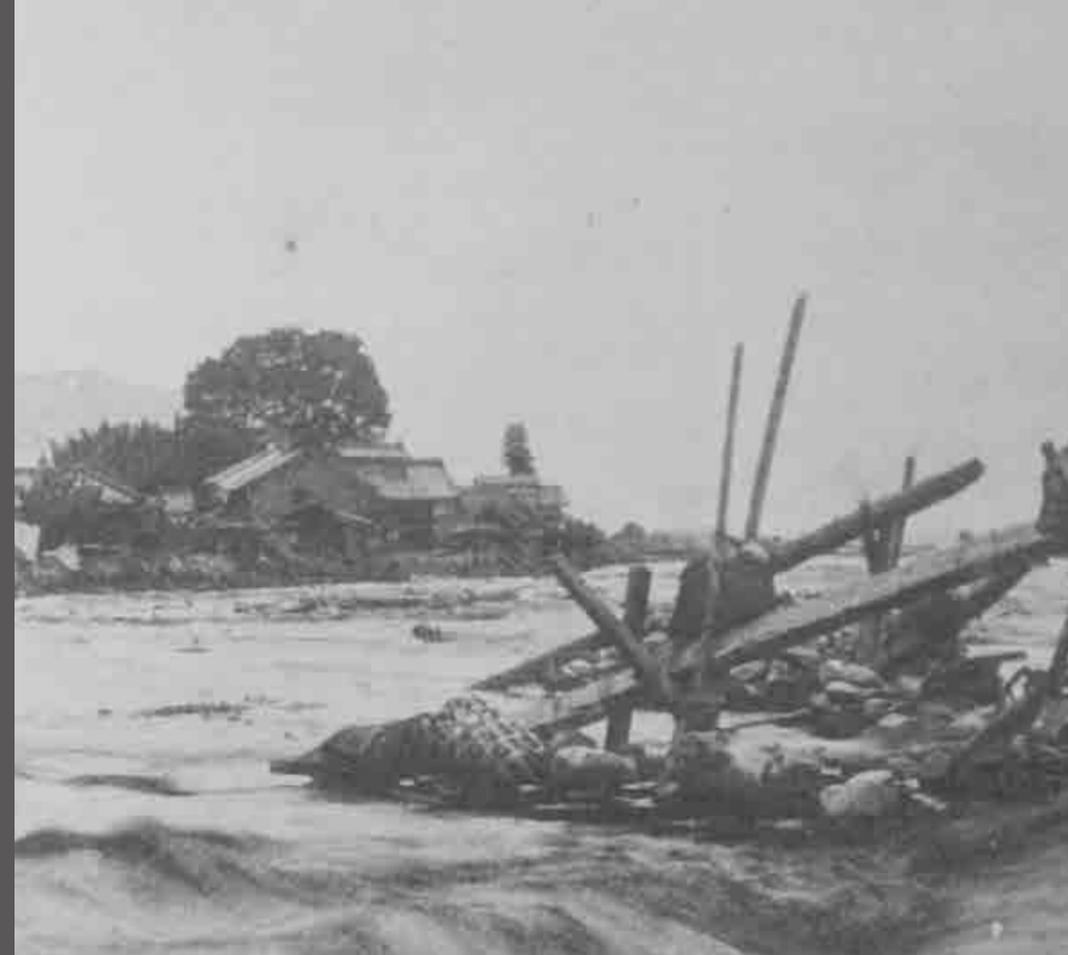
栗原付近のようす。右手前にある川倉（水の減勢や導流のため設置する丸太のやぐら）は激流に耐え切れず崩れ落ち、対岸の歌田集落では民家などが全半壊した。/ 山梨県立図書館所蔵
