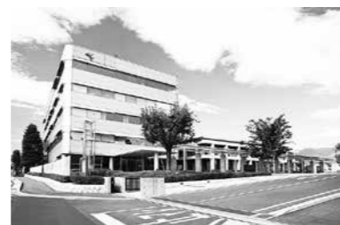
庁舎西館 CO2 削減・環境に 優しい改修工事
