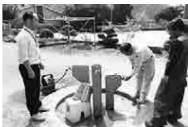
水道設備の点検を実施しました(写真・牧丘第一小学校)
