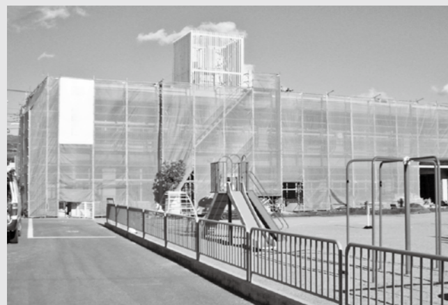
耐震工事を実施した山梨保育園 (改修済み) 保育所耐震補強改修事業 (平成22年度)
