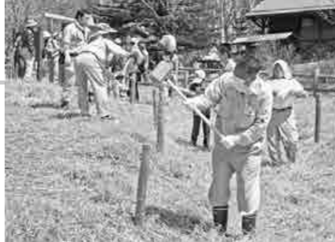
ハンマーでしっかり杭を打ちすえました
