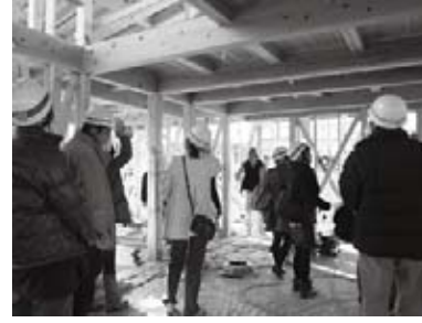
建築現場で業者の説明を聴きながら熱心に見学をする参加者。
