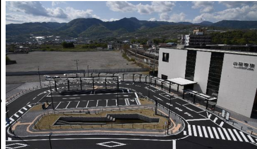
山梨市駅南口広場
