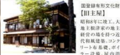
国登録有形文化財 【旧主屋】 昭和8年に竣工。大地主根津家の地主経営の場を持つ近代和風建築。コンクリート布基礎、ボイラー設備、屋内消火栓の導入、電気配線の埋込など、当時の先進的な技術が盛り込まれている。
