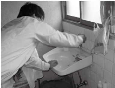
対象者宅で、宅内の蛇口の点検を行なう水道事業者。
