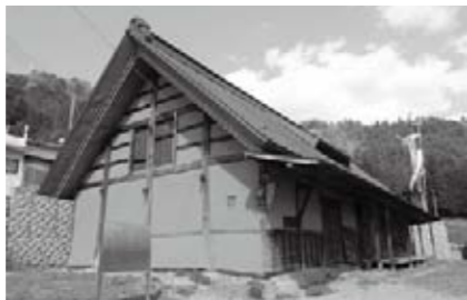
保存修理終了後の旧坂本家住宅
