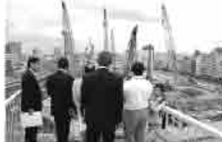
▶東武鉄道株式会社の工事から東京スカイツリー工事現場を視察する中村市長と市議会議員。（8月29日・市議会研修）
