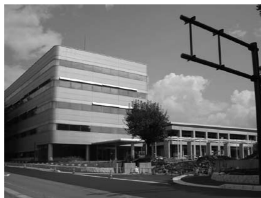
完成に向け工事を進めています
