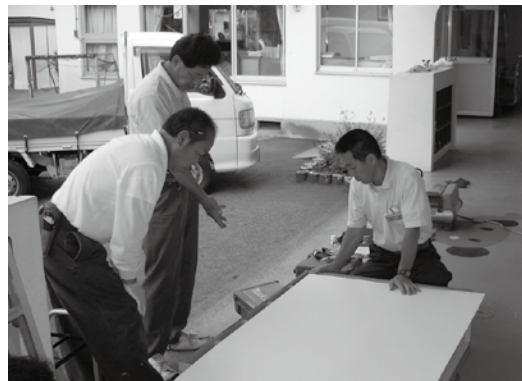
保育園で壁紙補修やドアの建付け調整をしました
