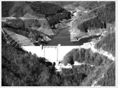
広瀬ダム（上）、琴川ダム
