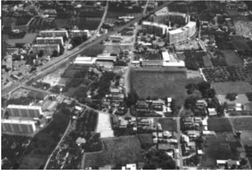
連方屋敷全体の様子(写真中央部・平成16年撮影)
