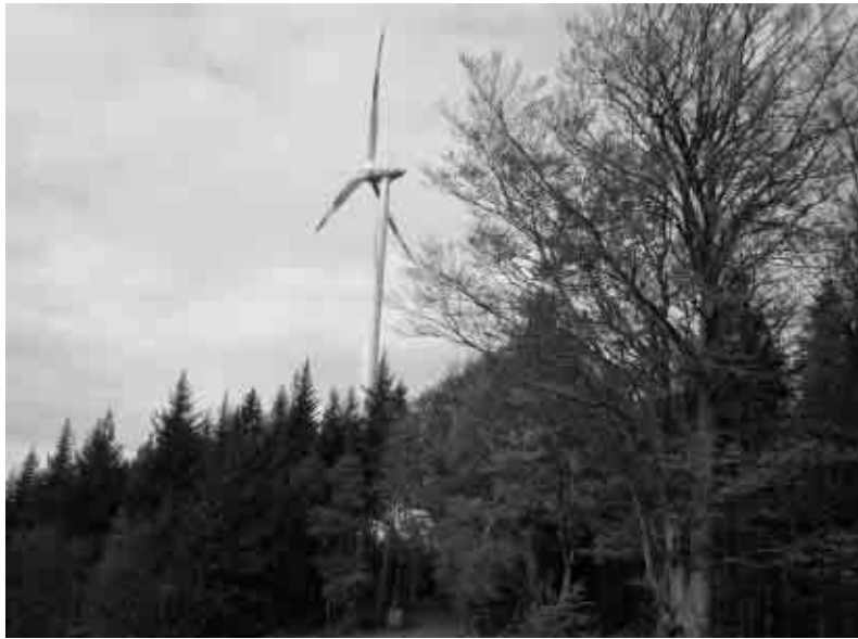
標高約 1,000 mの場所に設置されていた風力発電施設。
