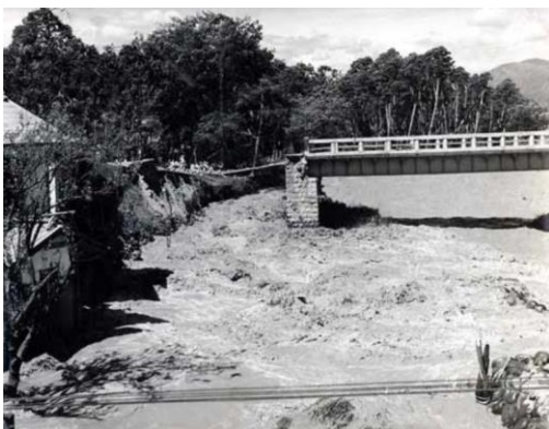
昭和34年7月山梨市万力地先笛吹川右岸破堤 (旧国鉄中央本線鉄橋上流付近)
