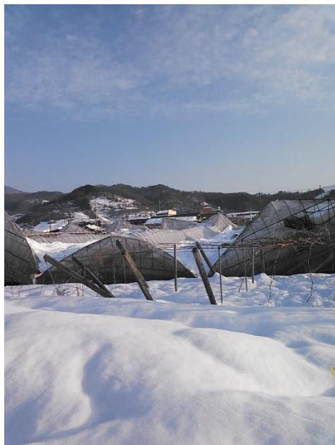
倒壊したビニールハウス(八幡地区)
