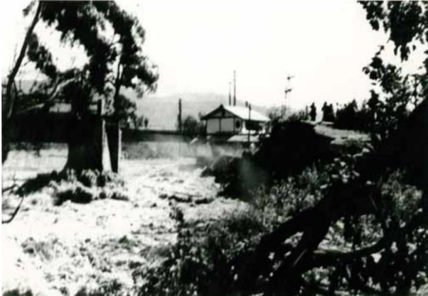
笛吹川右岸(山梨市万力根津橋取付道路流出)
