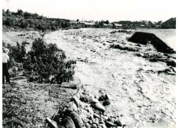
笛吹川左岸破堤(山梨市上神内川地先)
