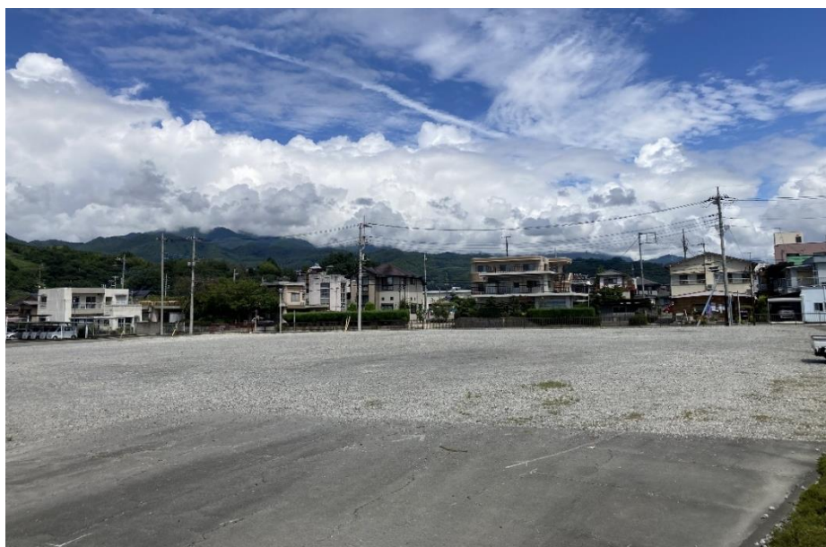
図 2 現在の様子(南東側から見た本跡地)
