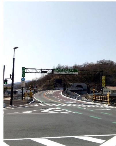
西関東連絡道路（岩手ランプ）
