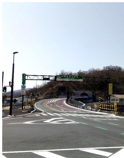
西関東連絡道路（岩手ランプ）
