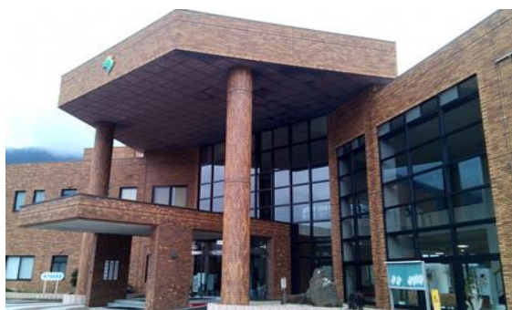
牧丘支所・牧丘町総合会館・諏訪公民館(複合施設)
