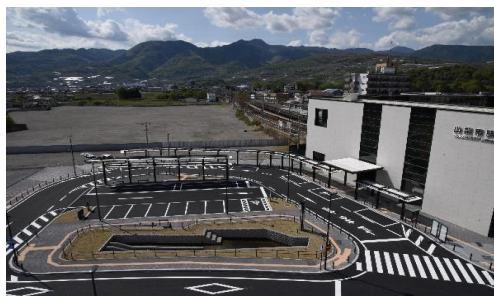
山梨市駅南口広場
