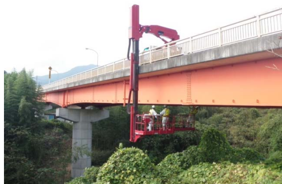
写真1 専門家による点検状況
