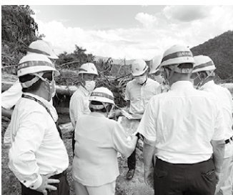
▲西保下地内小田野山の崩落現場箇所視察の様子
