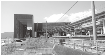
▲山梨市駅南地域整備事業 駅南口工事
