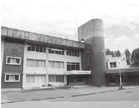
▲旧牧丘町総合会館(牧丘町YLO会館)
