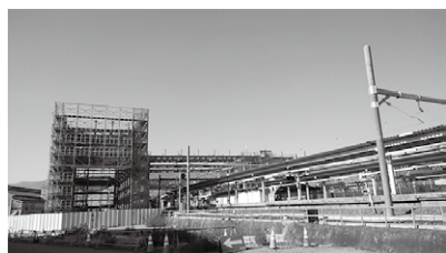
▲山梨市駅南北自由通路の工事の様子
