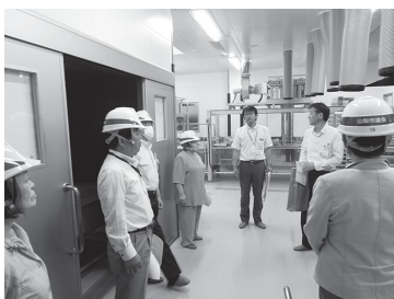
▲山梨市学校給食センター建設工事現場
