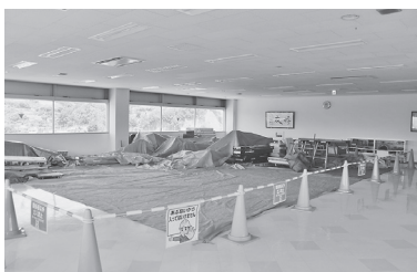
▲西館空調・照明設備改修事業
