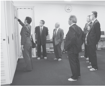
総務常任委員会のサーバー室 現地調査の様子
