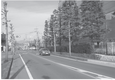
市道山梨市駅東山梨線(旧市役所より北側部分)の伐採や舗装の補修が行われた
