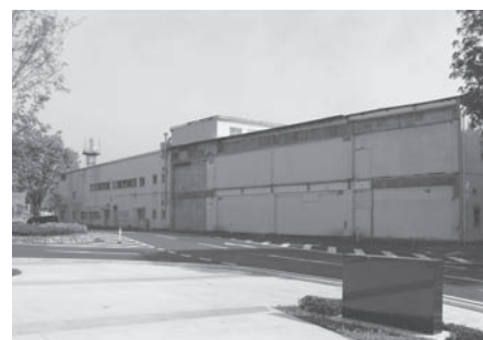
今後の活用方針が検討されている庁舎南棟
