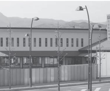
建設が進む地域交流センター
