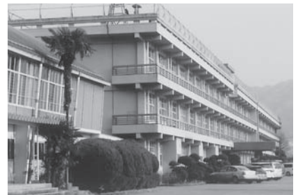
耐震補強工事が予定されている山梨北中学校
