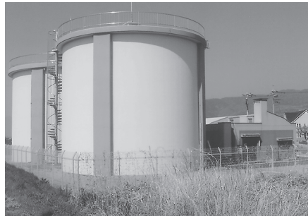
耐震対策が施されている大野配水池
