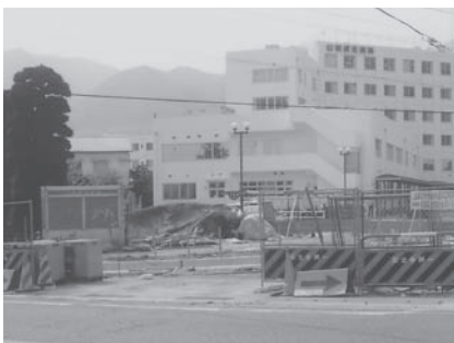
国道140号厚生病院入口交差点改良工事
