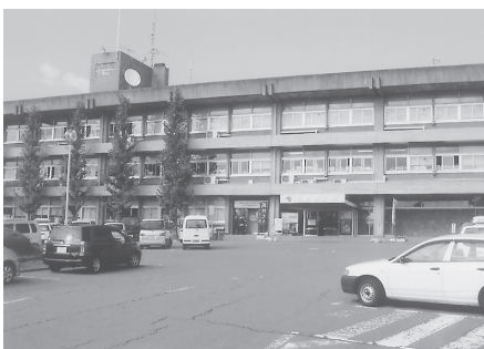
今後の活用が検討されている旧市役所山梨庁舎
