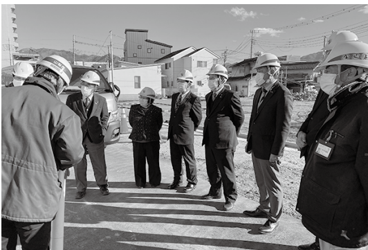
▲山梨市駅南口駅前広場整備事業箇所(電線類地中化整備箇所と補償物件の確認)視察の様子
