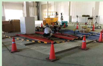
工事エリアの区画を設定して作業
