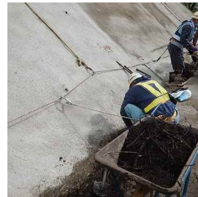
作業時なるべく離隔を確保
