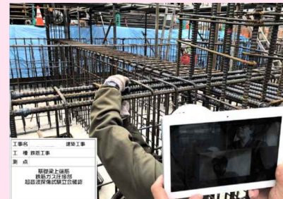
Webカメラを利用した遠隔検査
