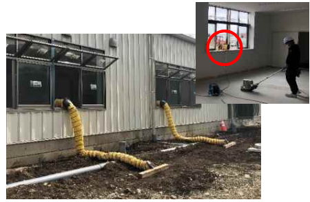
送風機を稼働し、埃を外部へ排出
