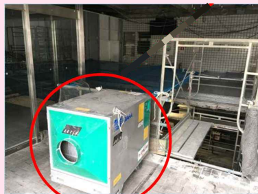
集塵機を設置し室内の換気を実施
