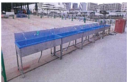
現場の手洗い場所の増設
