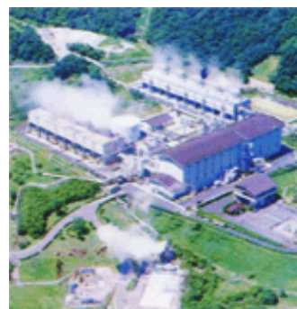
八丁原発電所（大分県九重町）
