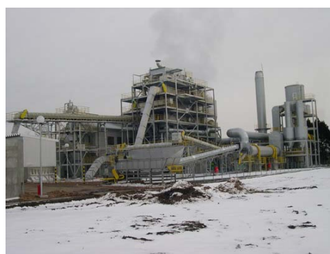
能代バイオマス発電所（秋田県）
