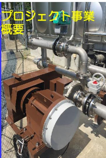
水口配水池マイクロ水力発電施設
