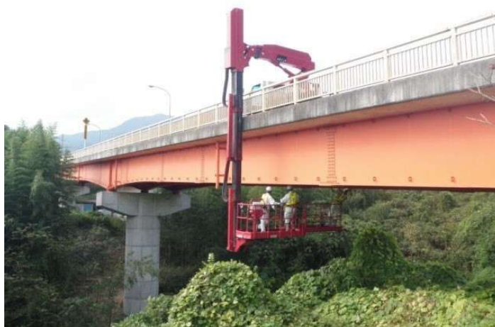
写真1 定期点検状況
