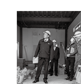
工事監査では、現地にて八幡分団第3部詰所建設工事の監査を実施しました。
