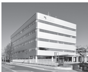
CO 2 削減・省エネ化改修工事を実施
